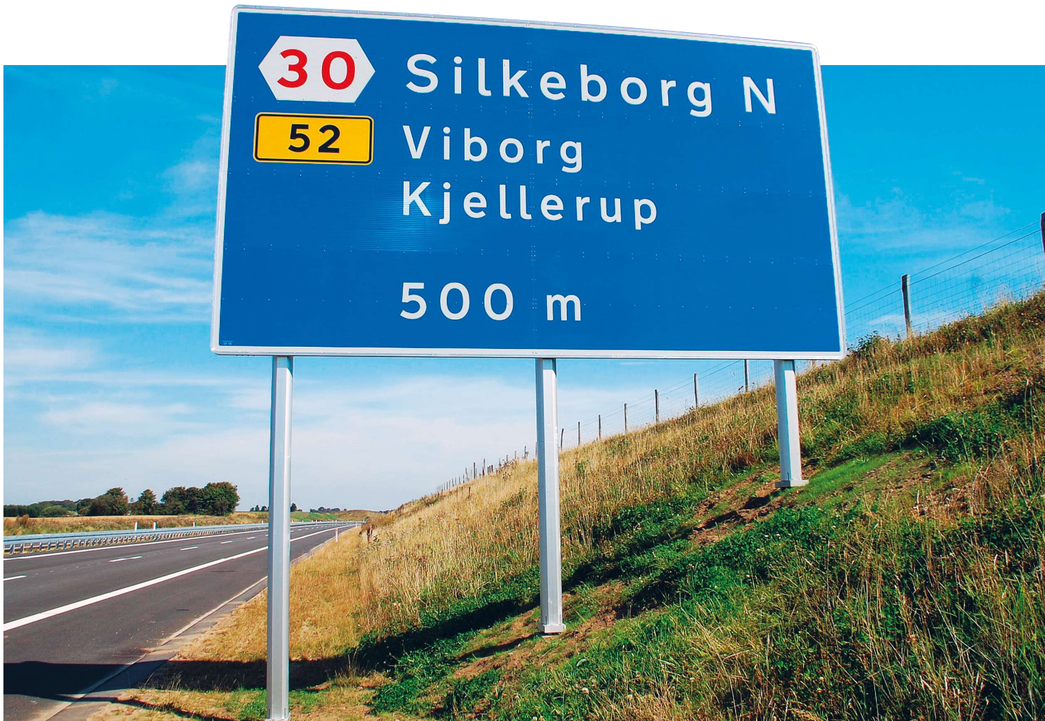
Sikker skiltning. Denne printede tavle er opsat på SeriPole eftergivelige master. Tavlen sidder så højt, at den ikke kommer ind gennem forruden ved en eventuel påkørsel. Foto: SeriQ Sign.
